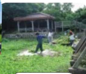
手作業で除去
